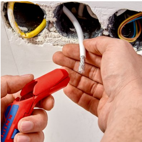
Удаление изоляции с отдельных проводов
