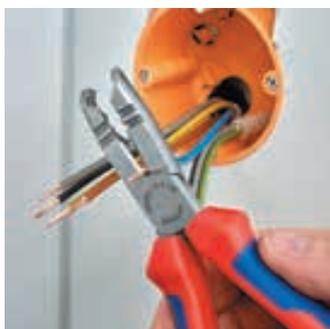
Укорачивание отдельных проводов.
