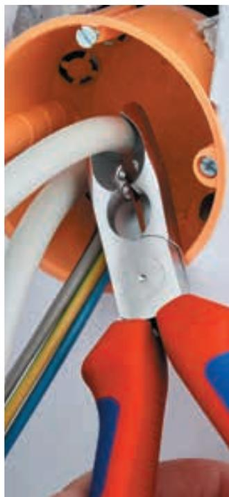
Удаление оболочки с проводов в глубине монтажной коробки скрытой установки.
